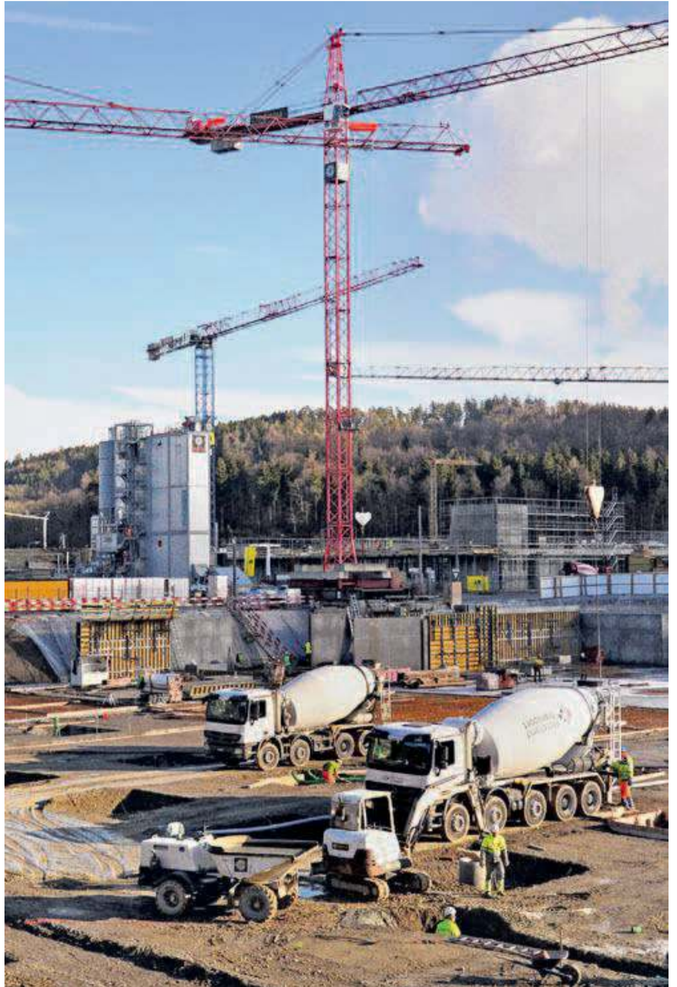
An der Sulzerallee in Neuhegi werden derzeit pausenlos neue grosse Wohnüberbauungen hochgezogen. Bild: Marc Dahinden
